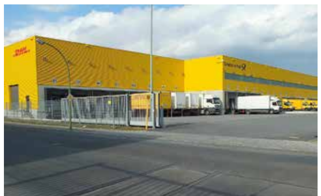
Abbildung 3.21: Berlin Mariendorf: statt auf den Verkehrsträger Schiene (im Vordergrund noch erkennbar) setzt DHL auch hier auf die Straße
