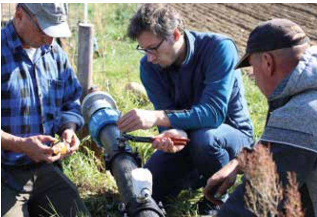
Abbildung 3.5: IIIM – Einbau der Sensorik an den Pumpenprototypen
